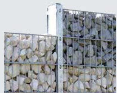
Steinmauer mit feuerverzinkten Pfosten
