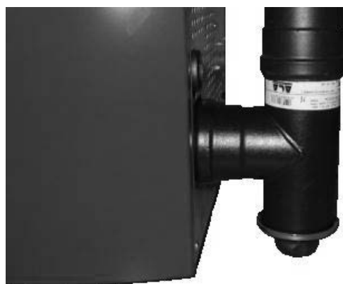
Fig. 29 - Reinigung des Rauchgaskanals
