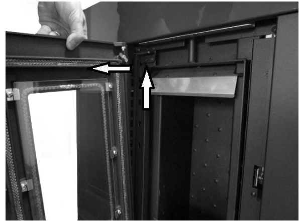
Fig. 19 - Ausbau der Tür
