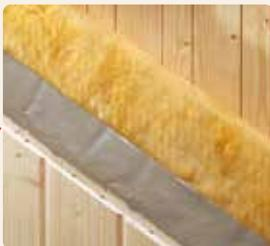
Unsere 68 mm Elementsaunen zeichnen sich durch eine hochwertige Isolierung aus. Diese besteht aus 40 mm dicken Mineralwolle-Isolierplatten, sowie einer Foliendampfsperre in den Wand- und Deckenelementen. Das garantiert eine saunagerechte Isolierung!
