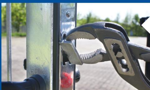
Änderung der Öffnungsrichtung durch Umdrehen der Schlossfalle.
