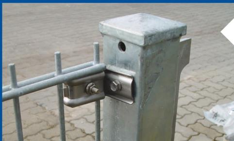
1. Setzen der Torpfosten in Beton und Montage der Zaunanschlüsse
