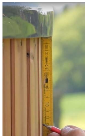
Abbildung 17: Lieferumfang, Markierung der Montageposition der Oberkante der Regalhalter, Positionierung des Regalbretts
