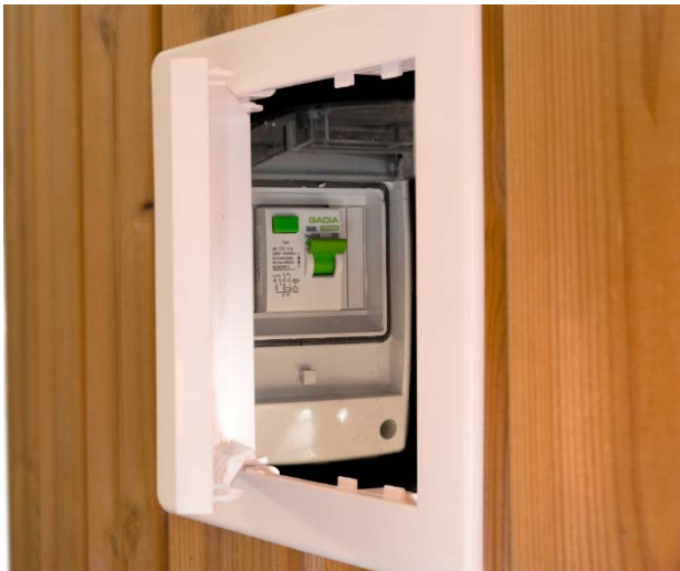
Abbildung 22: Position und Darstellung des FI (eingeschaltet)
