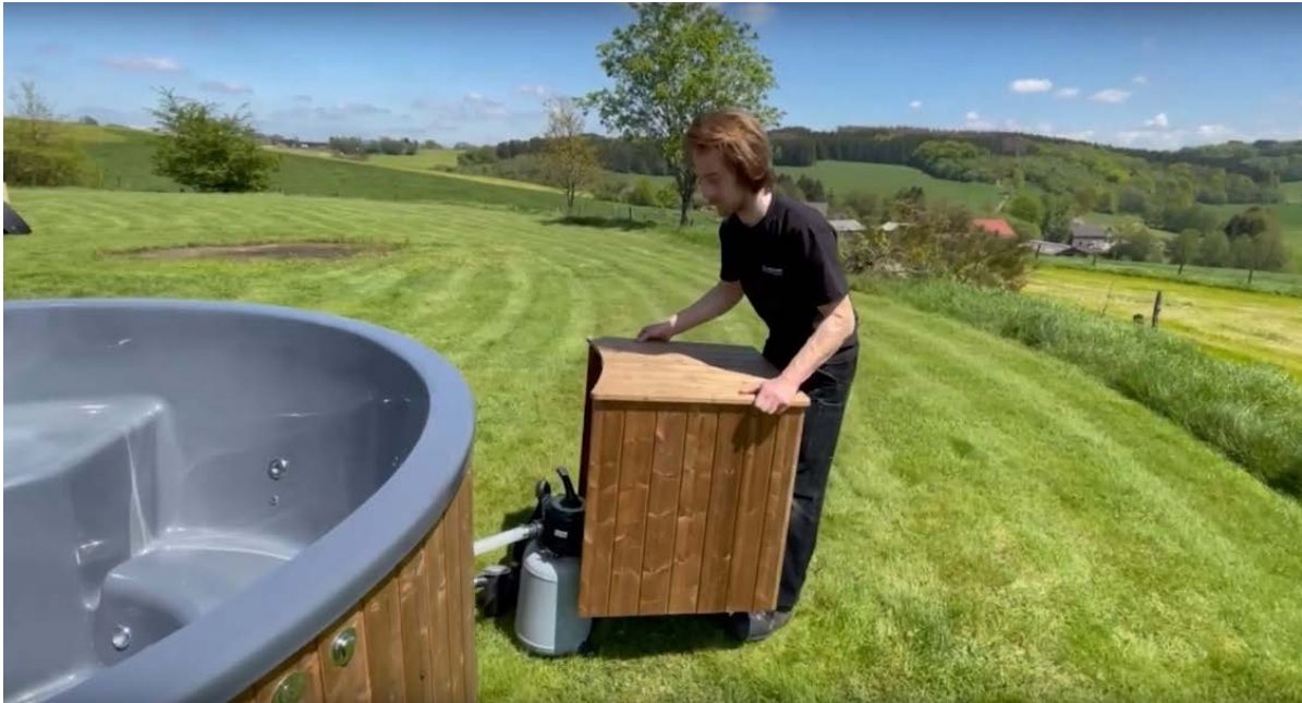
Abbildung 20: Verkleiden der Sandfilteranlage
