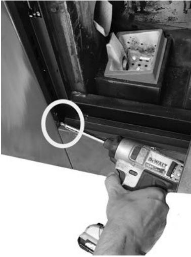
Fig. 44 - Entfernen der Schrauben 1
