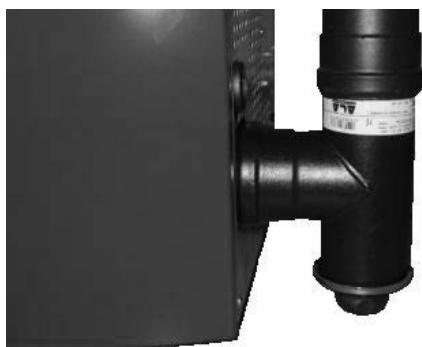
Fig. 63 - Reinigung des Rauchgaskanals
