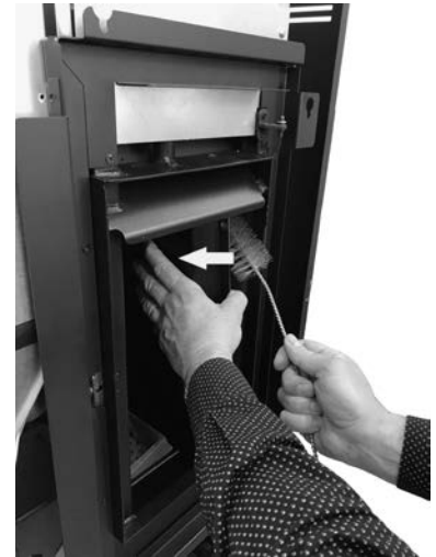
Fig. 68 - Mit einer Rohrreinigungsbürste reinigen
