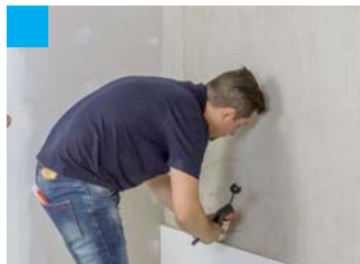
8. emv Save auf Längsstoss auftragen
