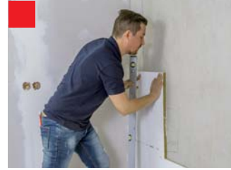
9. Platte für nächste Reihe setzen
