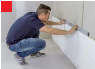
5. Plattenreihe setzen und ausrichten
