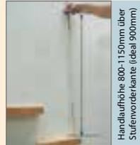
Handlaufhöhe 800-1150mm über Stufenvorderkante (ideal 900mm)
