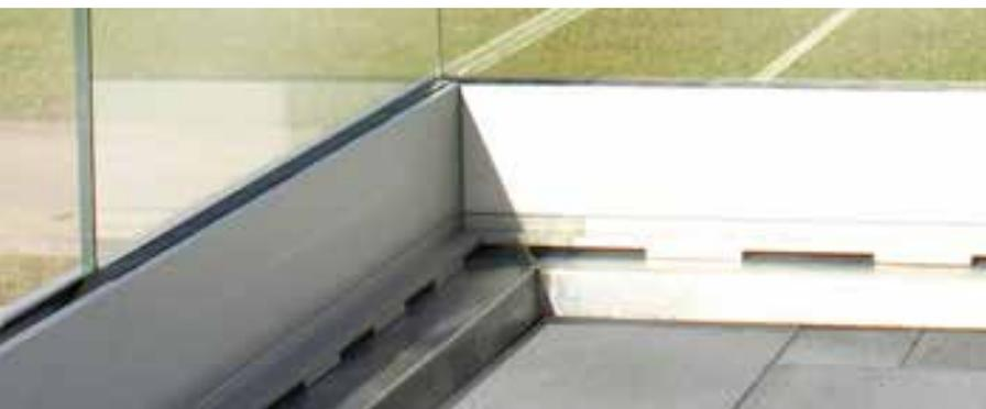
MR6 Sonderausführung mit Entwässerungsschlitz
