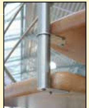
Fußplatten zur Befestigung an freitragenden Treppen
