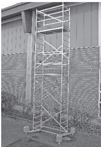
Grundgerüst mit erster und zweiter Aufstockung
